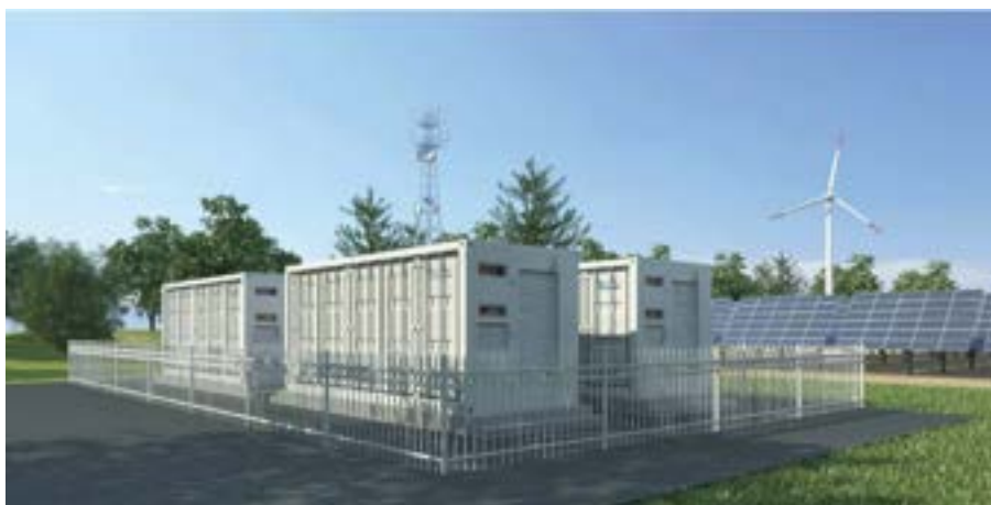
Figur 10. Eksempel på battericontainere.
